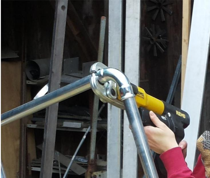
Abb. 49: Das Pressen der Heizungsrohre mit den Verbindungsstücken
